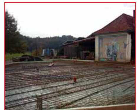
Solider Unterbau für Lehrküche und Kantine: die Bodenplatte
