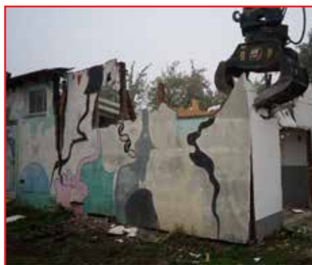
Platz schaffen: Abriss des Holzlagers
